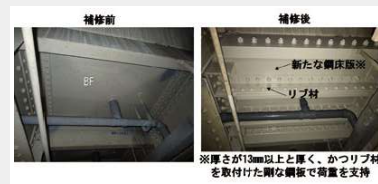
写真2：従来の補修方法(従来下支え)
