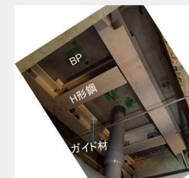
写真4：簡易下支えの実橋施工状況
